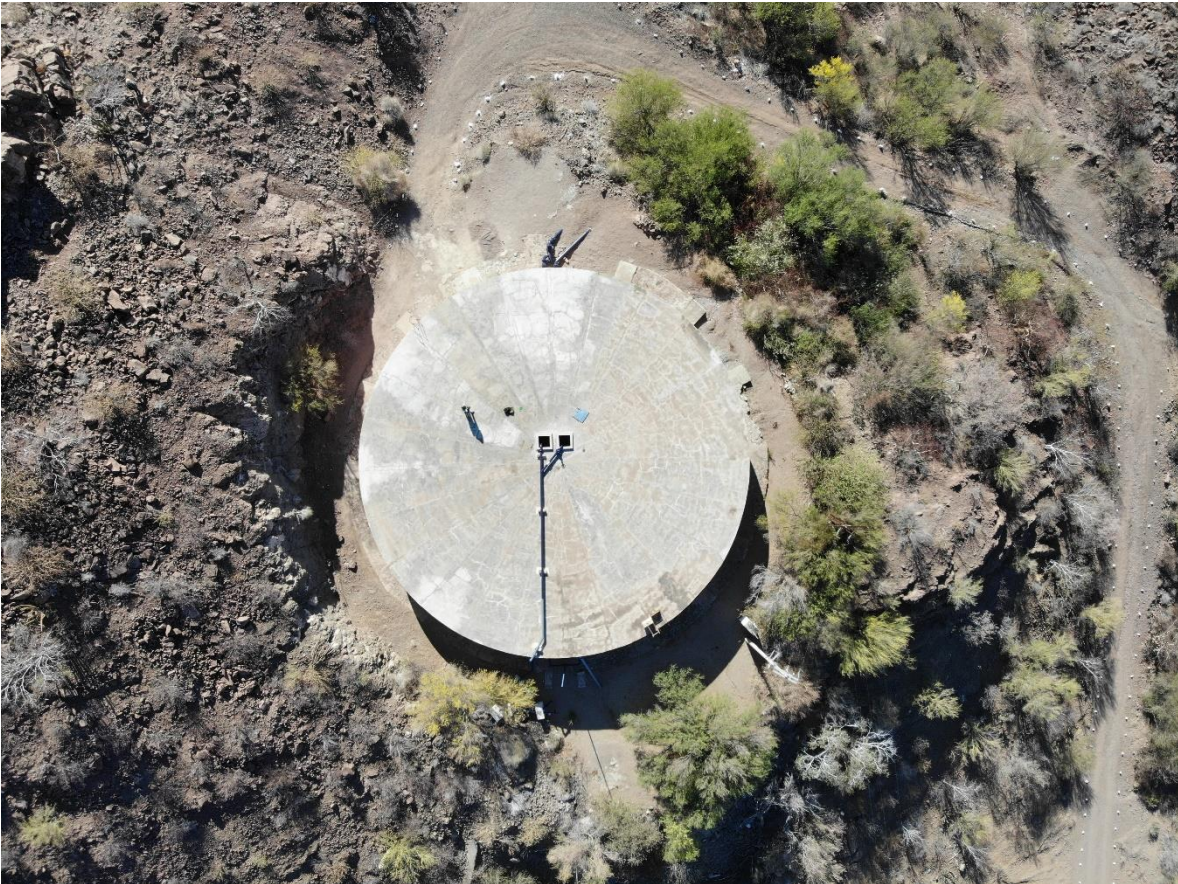
TANQUE DE AGUA.
